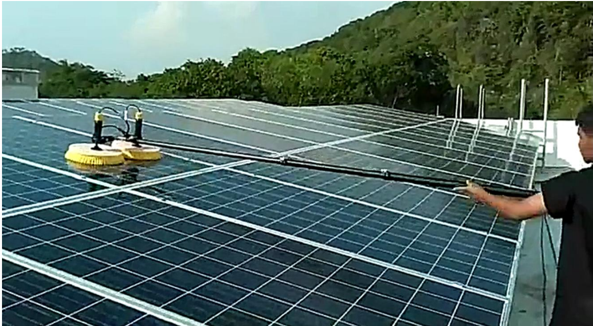
Hình 3. Sử dụng máy vệ sinh có chổi xoay
