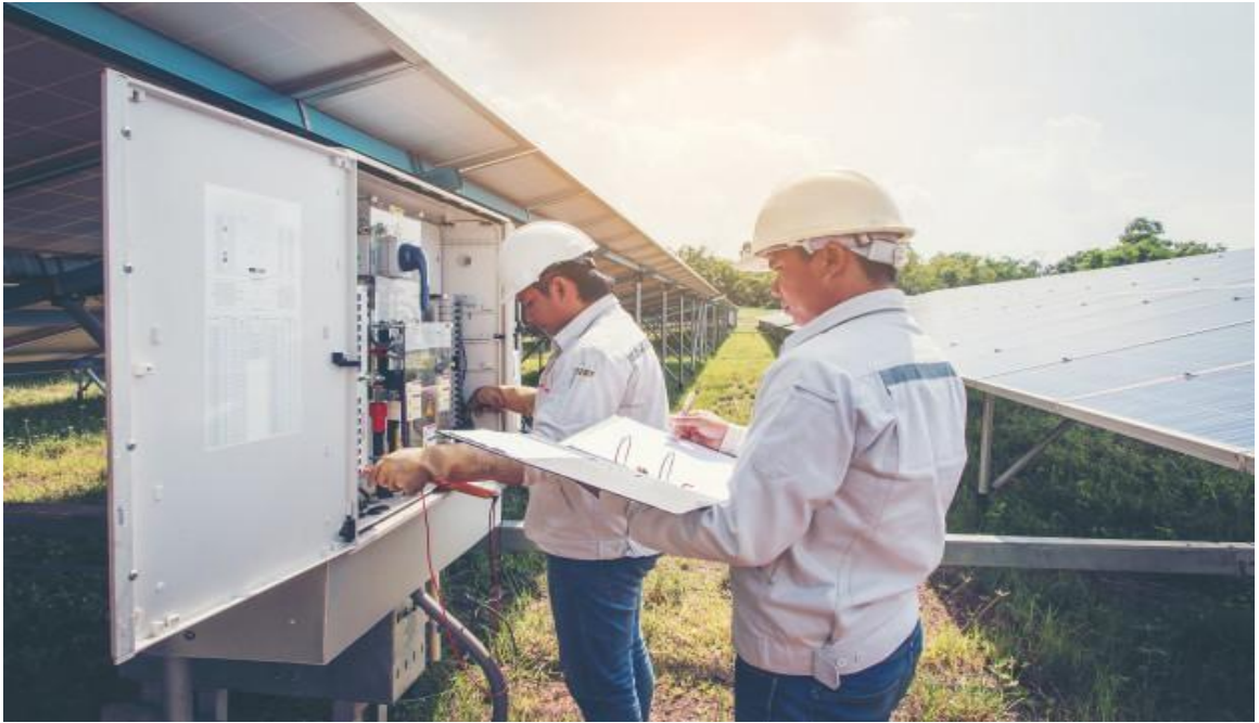
Hình 11. Kiểm tra tủ điện hệ thống
